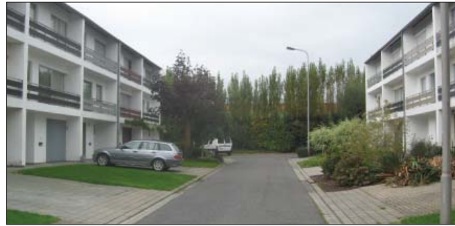
Deel 1 van de woonwijk bestaande uit woningen met 3 bouwlagen.
