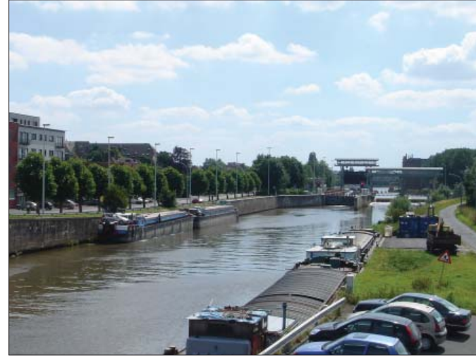
Naast het plangebied ligt het sluisencomplex van Harelbeke. Langs de Leie loopt een jaagpad dat ter hoogte van het plangebied via een fietsbrug naar de overzijde van een oude Leiearm oversteekt.
