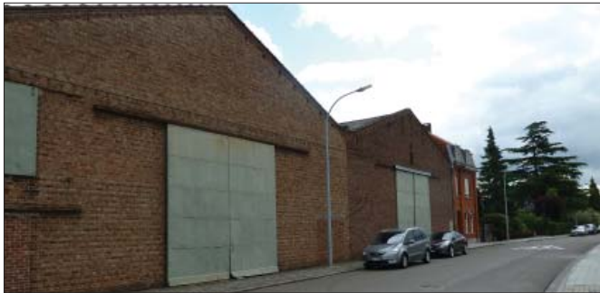
Complex van loodsen op de hoek van de Groenstraat met de Hoevedreef
